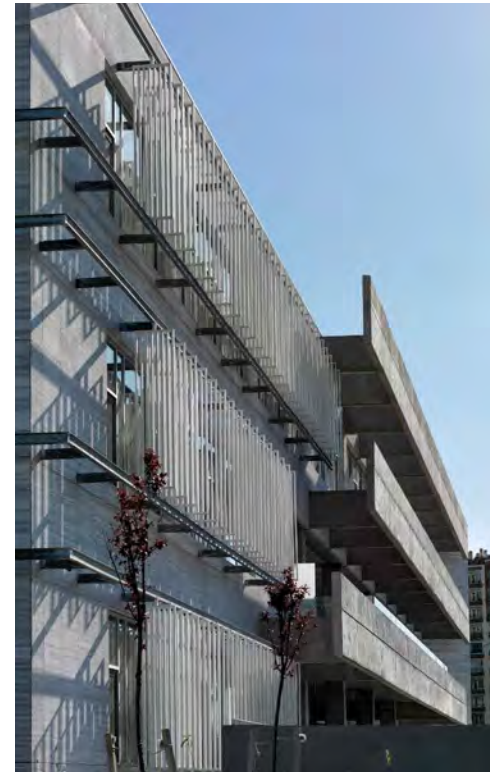
Diyarbakir Yenisehir Belediyesi Binası, Cemal Emden
