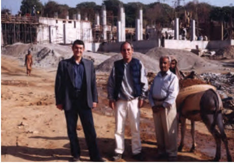
TC İslamabad Büyükelçilik Binası, inşa aşaması
